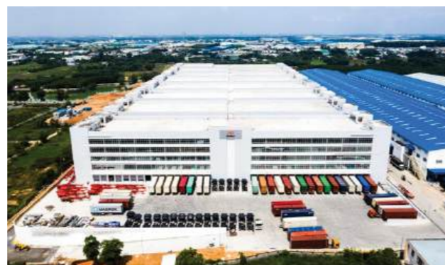
Dự án có mái lớn > 50,000 m 2 Project with a large roof area > 50,000 m 2
